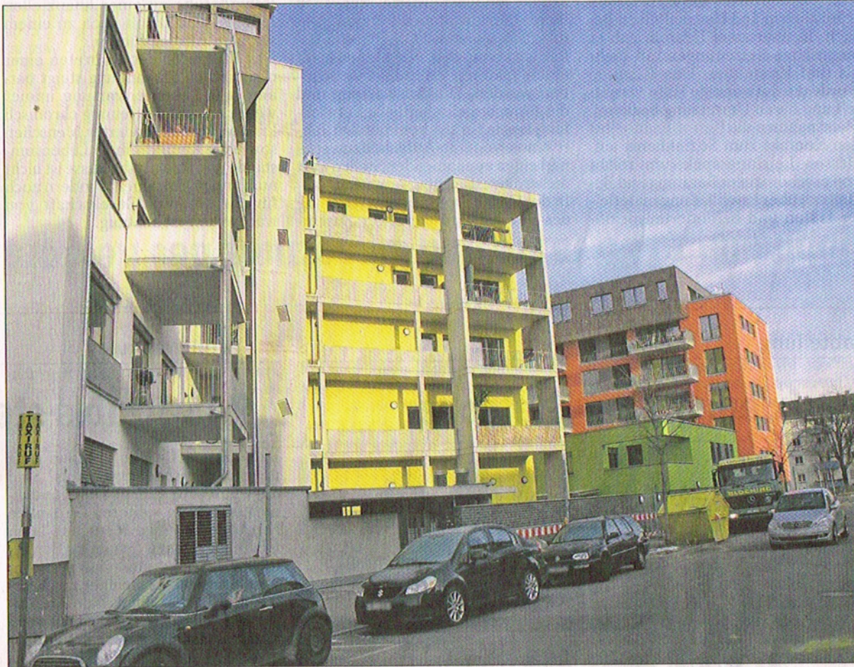
Schon durch die leuchtenden Farbkombinationen fallen die neuen Gebäude auf dem Friedel-Areal ins Blickfeld. Die Firma Archy Nova hat hier das große Bauprojekt nun abgeschlossen. Foto: Frey
