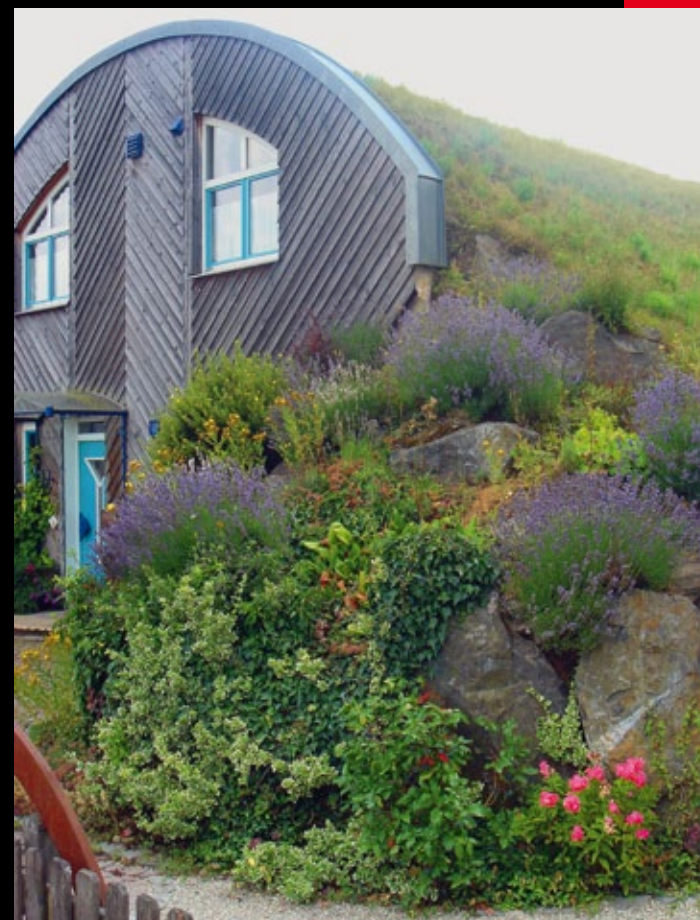
Auf stützende Wände kann durch die Gewölbekonstruktion verzichtet werden. Für die Innenraumaufteilung ergeben sich dadurch verschiedene gestalterische Möglichkeiten.
