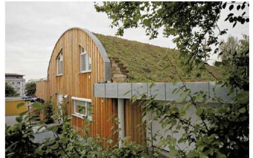
Die Erdschicht auf dem Hügelhaus sorgt für zusätzliche Wärme-Isolierung.
